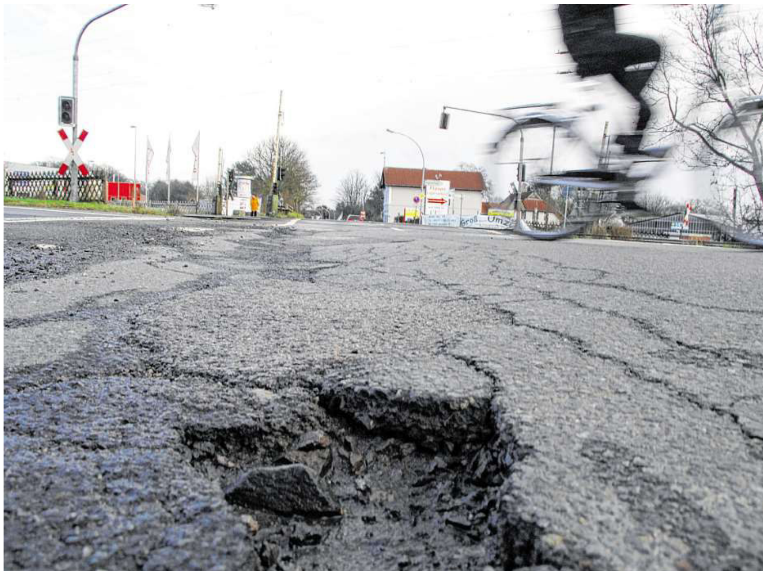
Straßenanierung beschäftigt nicht nur die Stadt. Das Flickern der Löcher in der Bremer Straße (K 5) ist Sache der Kreisverwaltung.
